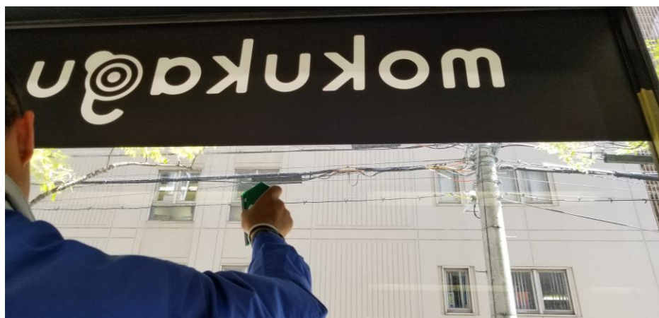
清掃作業(スクレーパー、アルコールにて汚れ、油脂除去)
