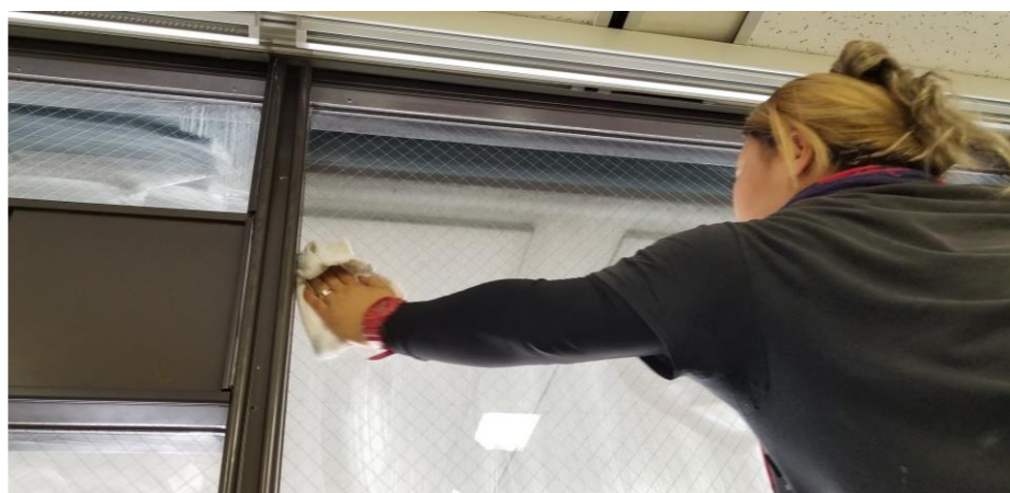
清掃作業(コンパウンドにて汚れ、油脂除去)
