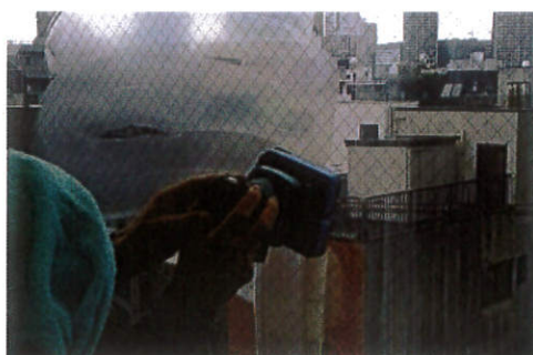
コンパウンド作業、終了後IPAにて完全ふき取り
