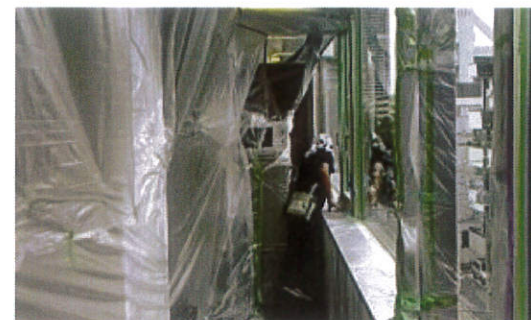
養生作業終了
