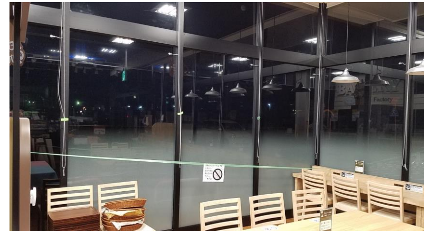
施工完了 5日間は触らないでください。
