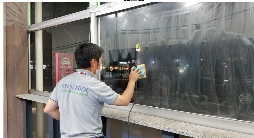
清掃作業(コンパウンドにて汚れ、油脂除去)
