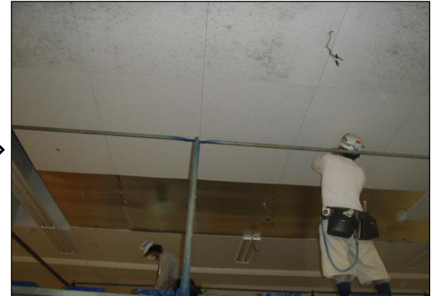
SM天井張替工事
