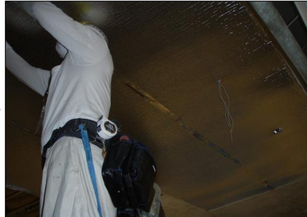
SM天井張替工事
