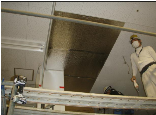
SM天井張替工事
