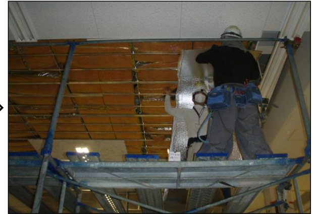
SM天井張替工事
