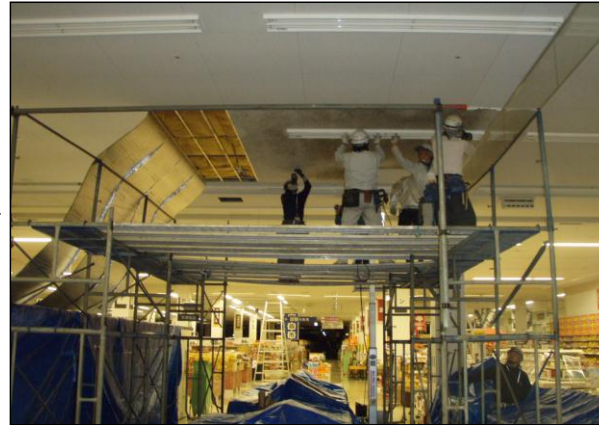
SM天井張替工事
