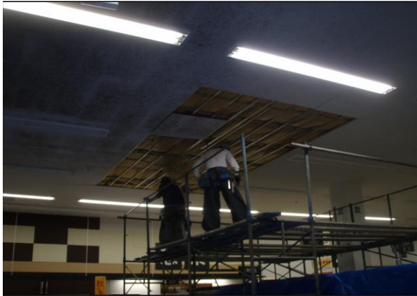
SM天井張替工事
