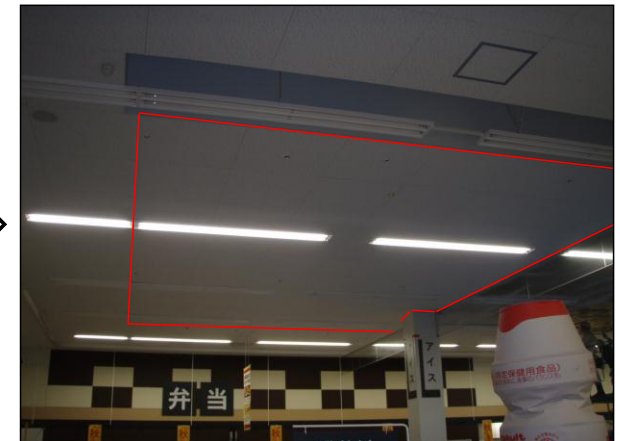
SM天井張替工事
