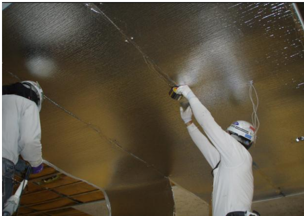
SM天井張替工事
